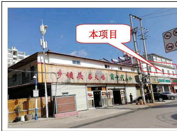
项目西面相邻和1楼现状
