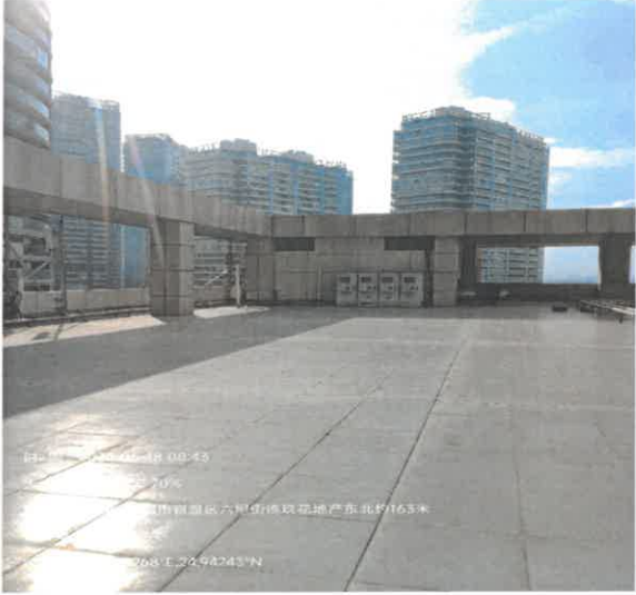
机房所在地照片
