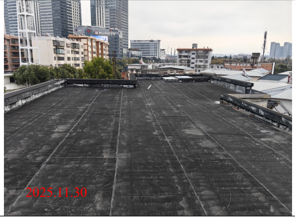
本项目大楼楼顶
