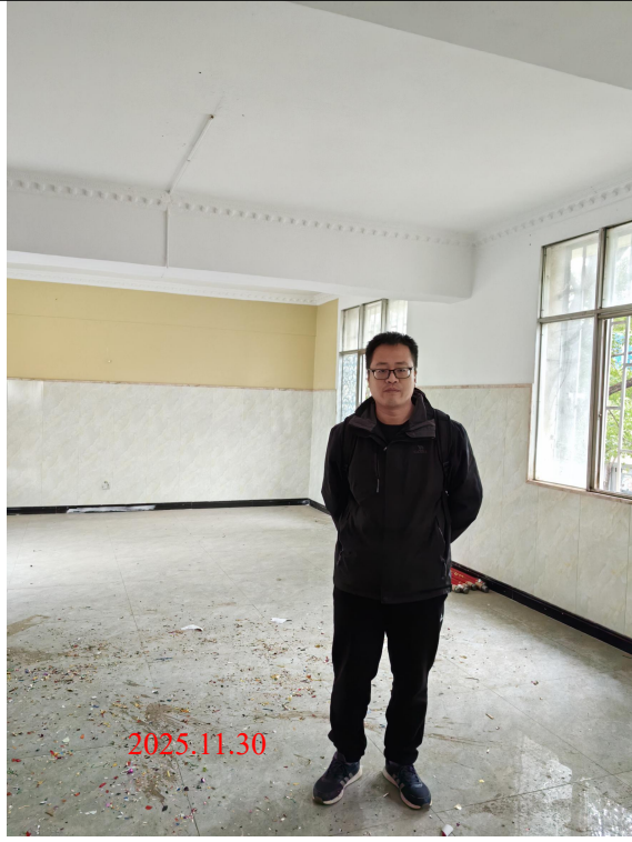
本项目实验室二楼
