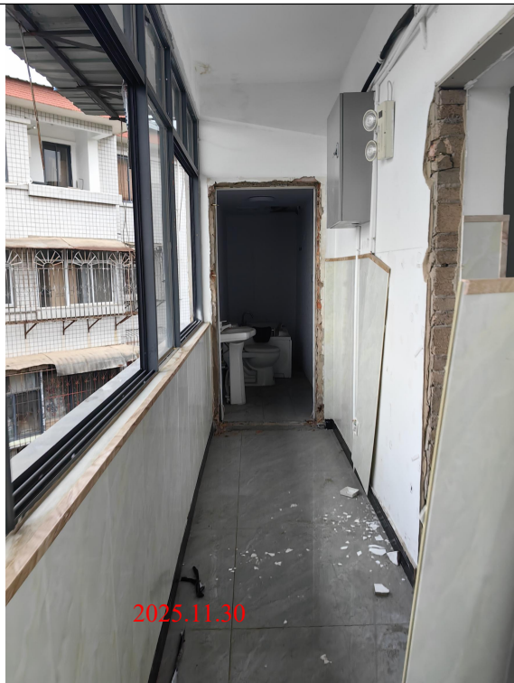
本项目实验室三楼
