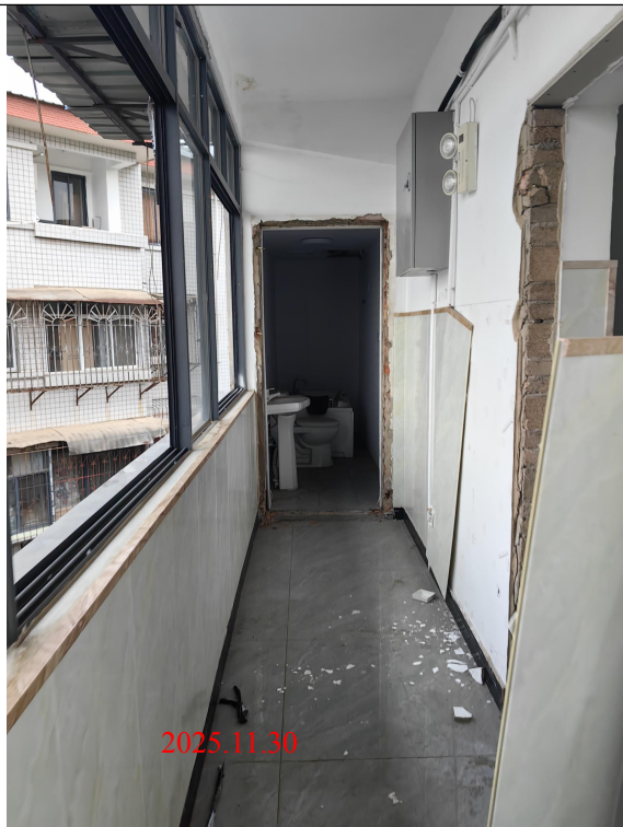
本项目实验室三楼
