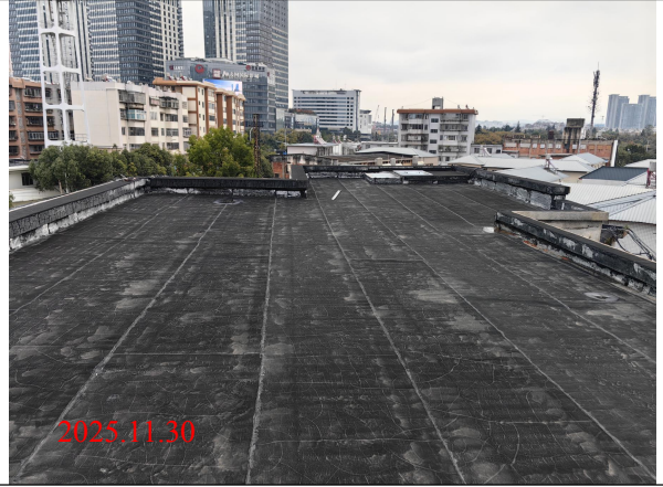
本项目大楼楼顶
