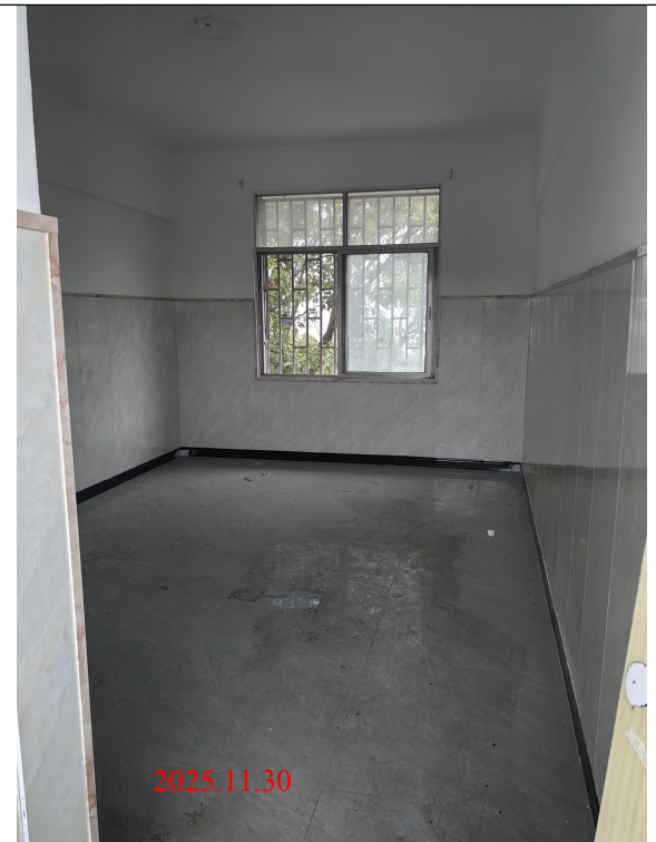
本项目实验室三楼
